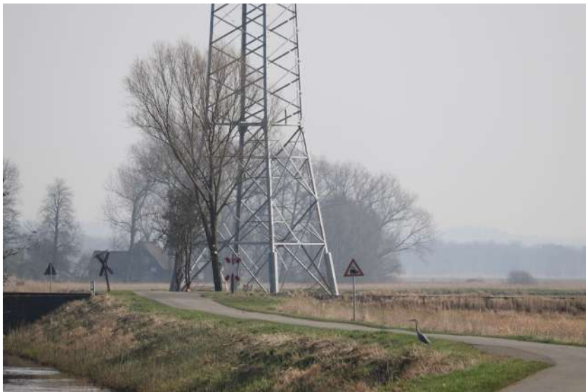
Abbildung 1: Freileitungsmast bei Eichholz. Man beachte rechts unten den Graureiher.
